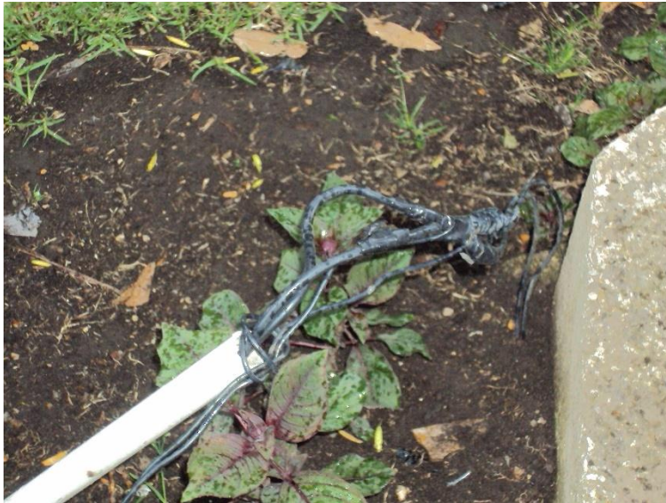
Ductos y redes expuestas en la superficie
