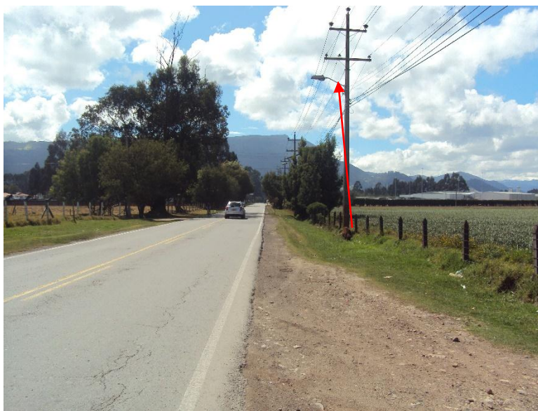
Falta de altura de instalación de la luminarias
