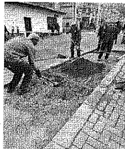
Reparación adoquín policía pompeyano
